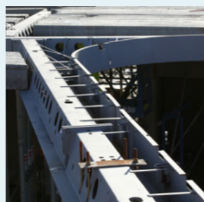
Integrované debnenie umožňuje vytvorenie atypicky tvarovaných nosníkov
