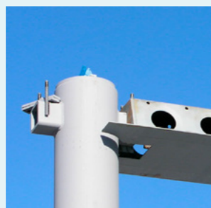
Konzolový spoj s oceľovým stĺpom
