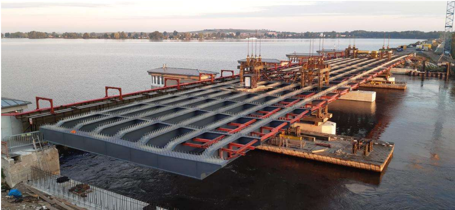
Most ev. č. 52-059 u Pasohlávek, projekt SHP s. r. o.
